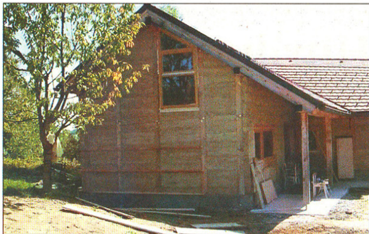
Primer gradnje enodružinske ilovnate hiše v Prekmurju (2007). Avtor projekta je arhitekt Robert Veselko.
